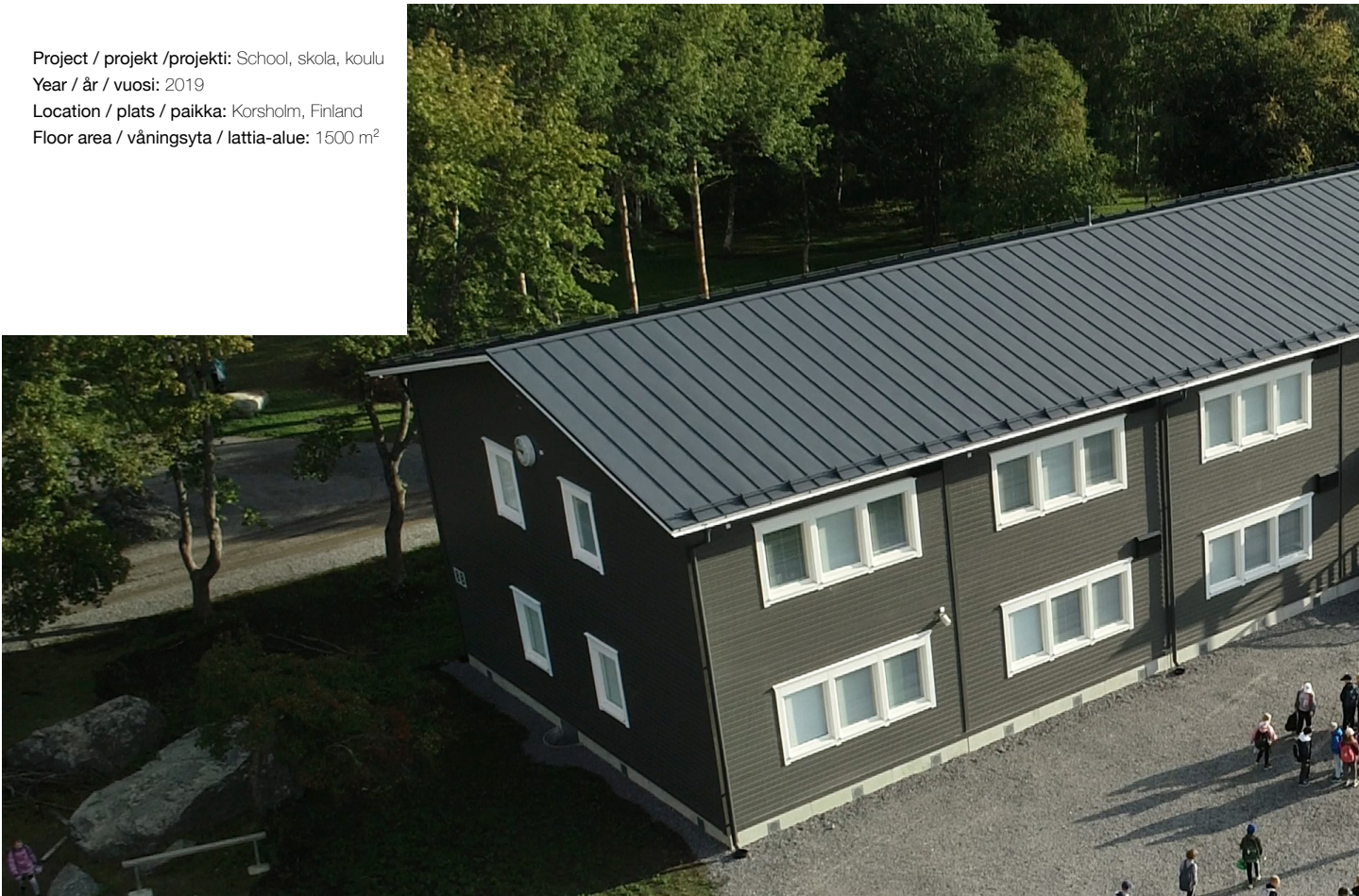
The fully assembled school building / den färdig monterade skolbyggnaden / valmis asennettu koulu
