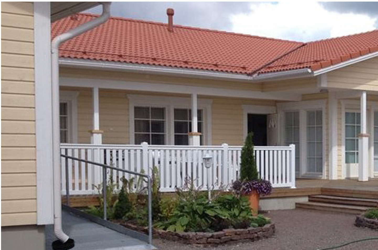
The building seen from the courtyard / byggnaden från innergården / rakennus pihalta
