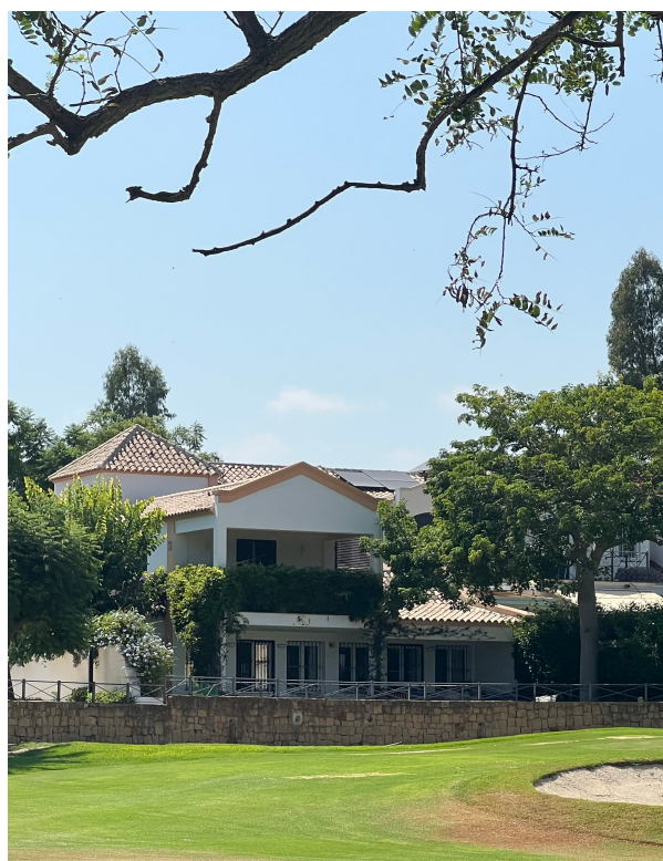
Facade facing the golf course / fasad mot golfbana / julkisivu golfkentälle päin
