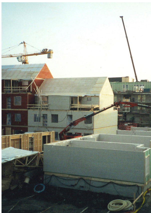
Element assembly / elementmontering / elementin asennus
