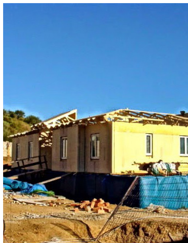
wooden construction assembly / träkonstruktions montering / puurakennusten asennus
