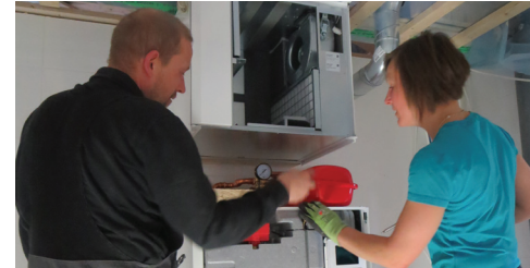
Grundarbeten utförs av kunden enligt måttitning från oss. El, vatten och avlopp bör vara färdigt in-dragna i grunden.
