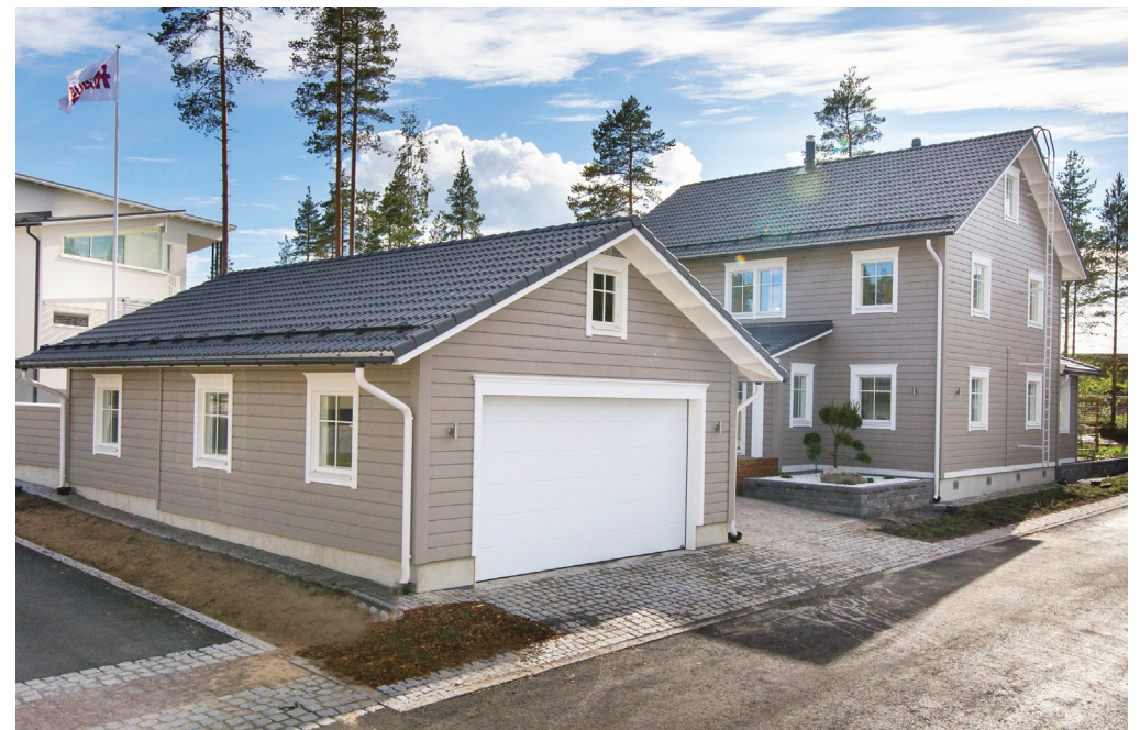
Moduulit nostetaan paikoilleen. Sähkö, vesi ja viemärinti liitetään verkkoon. Katto nostetaan paikalleen. Tämän jälkeen lisätään terassit, parvekkeet, kuistit ja muut mahdolliset lisäosat.
