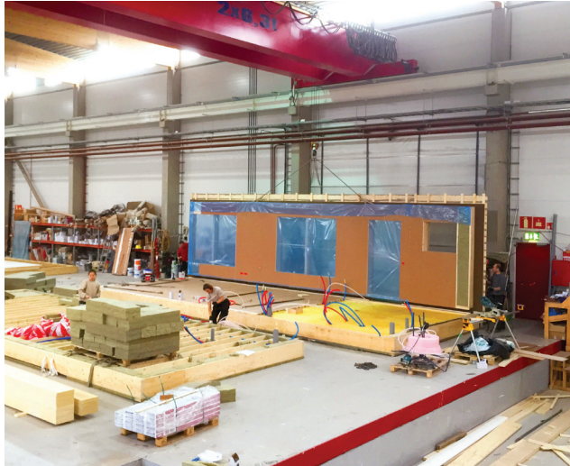
Huset tillverkas som stora volymelement helt färdigt med inredning, ytmaterial och installationer inomhus i fabriken.
