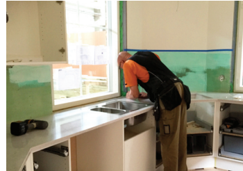
Valmistalosi rakennetaan tilaelementeistä talotehtaalla sisätiloissa. Moduulit sisustetaan ja lvis-asetukset tehdään valmiiksi jo ennen toimitusta.
