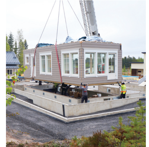
Asiakas vastaa perustuksesta. Toimitamme kaikki tarvittavat ohjeet ja mittapiirroksset. Perustuksissa tulee olla valmiina liitokset sähkölle, vedelle ja viemäriin.
