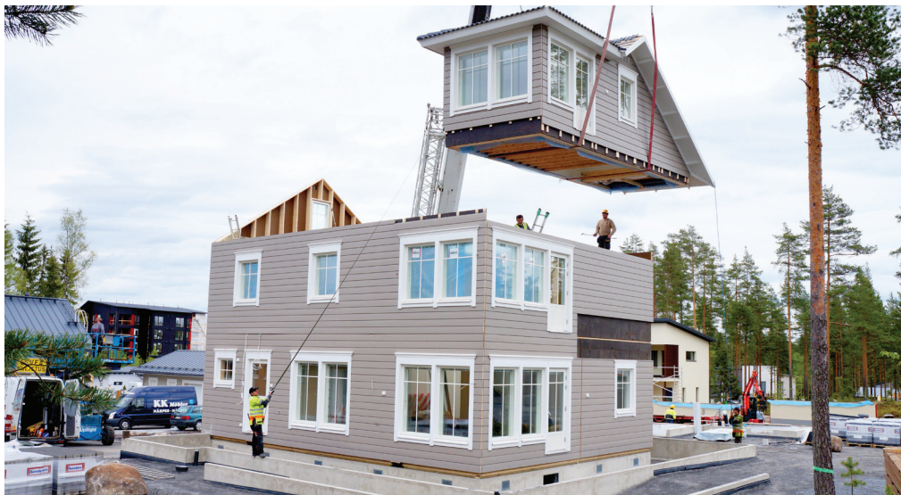
Volymelementen lyfts på plats. El, vatten och avlopp kopplas in. Taket lyfts på plats. Därefter följer monteringen av kompletteringar i fasad: balkonger, terrasser mm.
